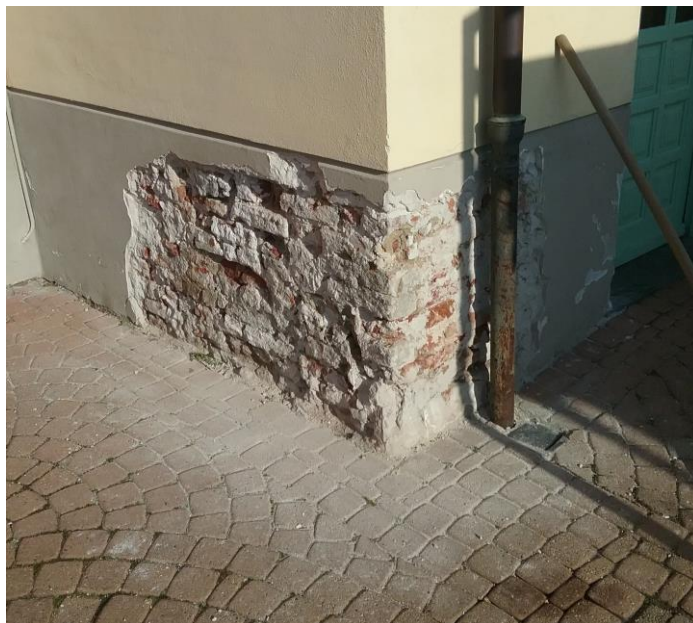
Dettaglio muratura spigolo edificio ottocentesco (muratura oggetto di rinforzo mediante intonaco armato)
