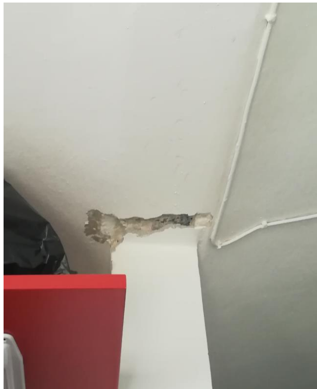
Dettaglio della putrella e voltino del solaio del piano primo a copertura dell'ex latrina e vano scale piano terreno
