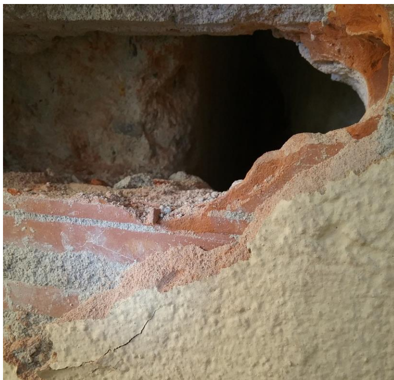
Dettaglio muratura perimetrale edificio Est, avente struttura in c.a.
