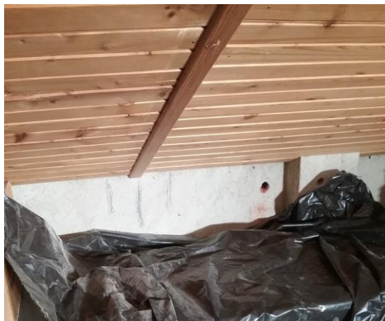
Determinazione della composizione e dello spessore dei muretti di base della copertura lignea manica Est.
