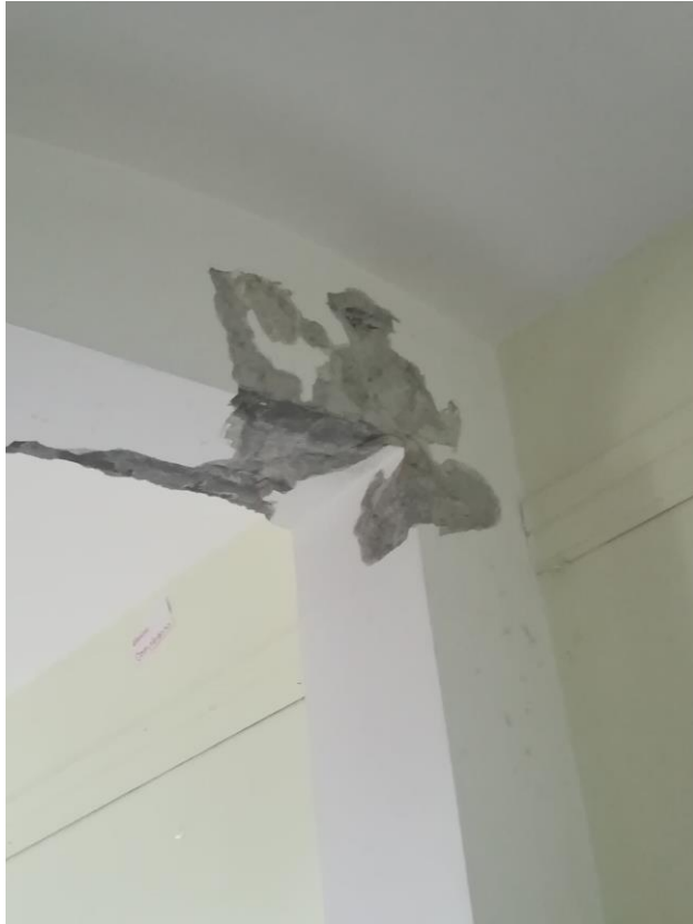
Dettaglio trave di rinforzo in mezzzeria del solaio a voltini realizzata mediante l'accoppiamento di n.2 profili IPE 180 in appoggio su n.1 pilastro in c.a. avente dimensioni di 24*24cm e su muratura portante.
