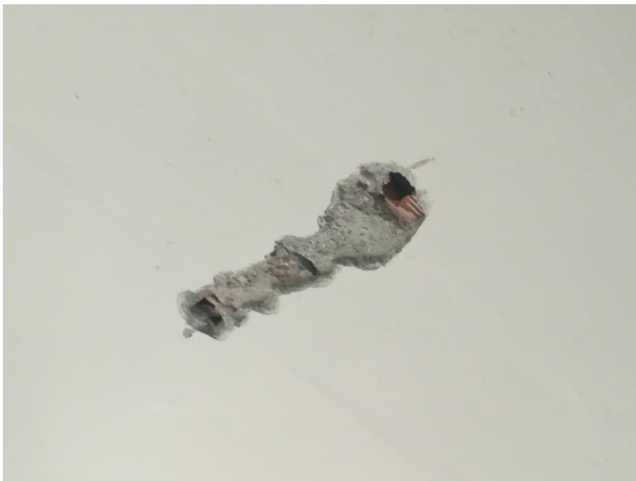
Dettaglio solaio in laterocemento del piano primo con doppio travetto prefabbricato, testata del corpo ottocentesco
